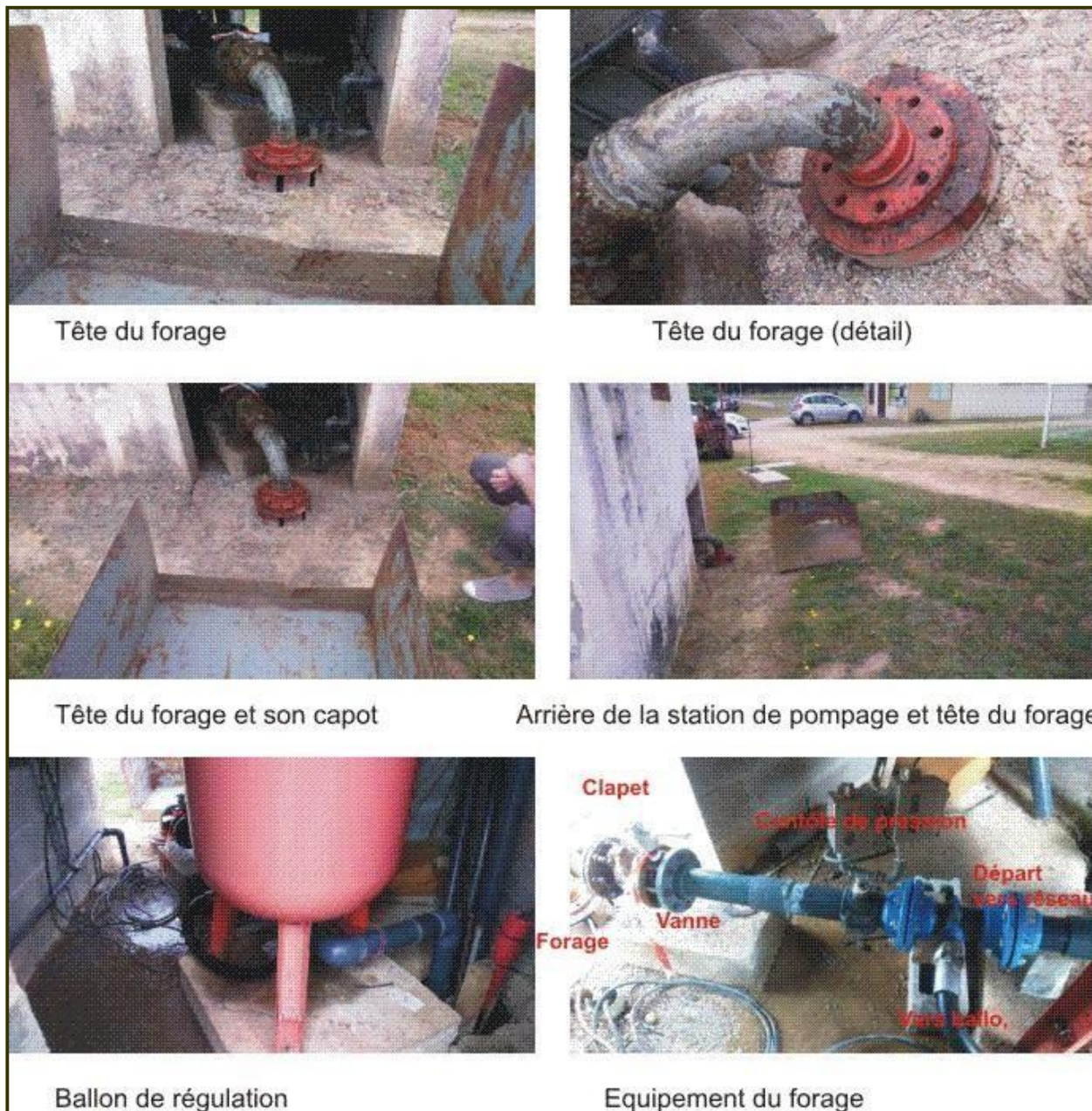
Figure 4 : Photographies du forage du stade de Ménasse
